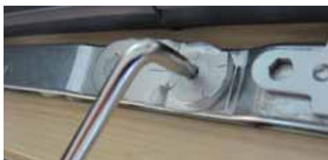
Stranska nastavitve zgoraj s ključem Torx 15
